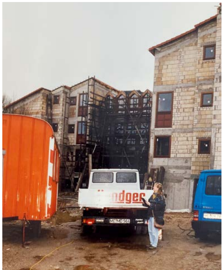
Richtfest des Wohnhauses an der Abtskücher Straße
