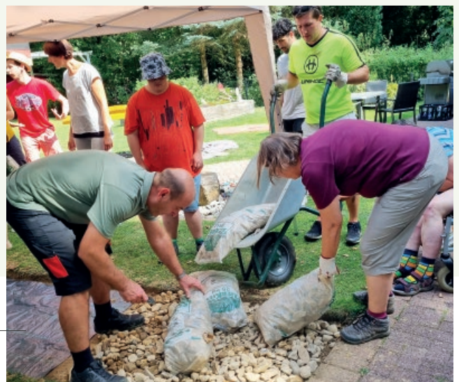
Hier entsteht ein sieben Meter langer Reha-Pfad.
